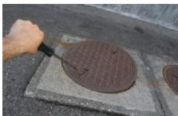
油水分離槽を開けて確認！
